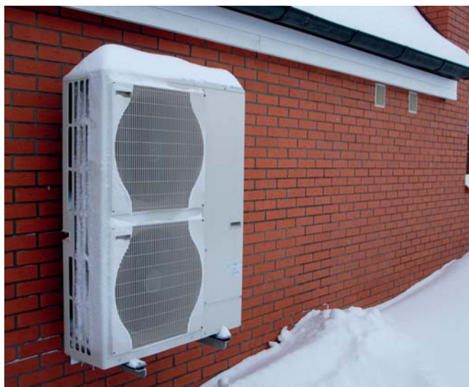
Venkovní jednotka japonského tepelného čerpadla – dělená montáž (split systém).
